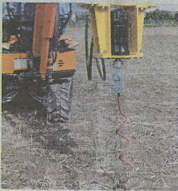
楽に杭が打ち込める「楽くるショベル」
